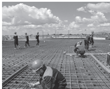
Studentų statybos būrys dirba statybvietyje – suriša armatūrą. 2014
